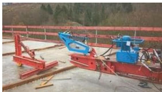
La serie tirfor® TU-A è adatta per lo spostamento automatico di carichi su lunghe distanze. Molti cantieri hanno una fornitura d'aria usando un compressore. Il tirfor® pneumatico può essere collegato a questo compressore e ha un'unità di controllo standard. Se si perde la pressione dell'aria, la serie tirfor® TU-A può anche essere azionata manualmente.
